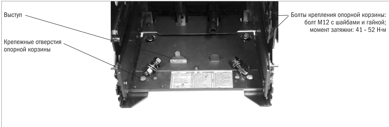
Рисунок 4. Крепление опорной корзины
